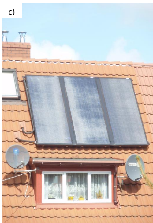
Fot. 2. Fotografie a – c są przykładem zaporowanych kolektorów płaskich, dla których wykonano zdjęcia w godzinach popołudniowych na typowych instalacjach indywidualnych 1) .
