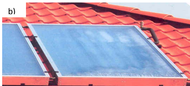
Fot. 2. Fotografie a – c są przykładem zaporowanych kolektorów płaskich, dla których wykonano zdjęcia w godzinach popołudniowych na typowych instalacjach indywidualnych 1) .
